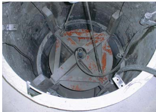
Ofenzustellung mit NKH
