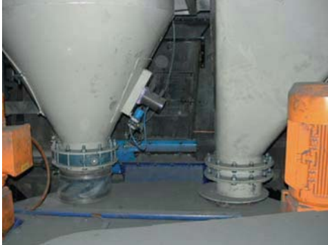
Abreinigen von festen Anbackungen mit Druckluft-Kolbenvibratoren
