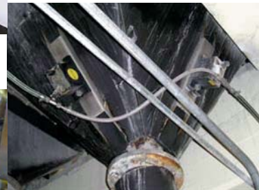
Vermeiden von Brückenbildungen mit Druckluft-Kreisschwingern
